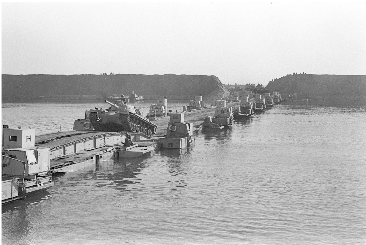
תיקון ארעי של גשר הדוברות באמצעות טנק גישור באדיבות ארכיון צה"ל ומערכת הביטחון
