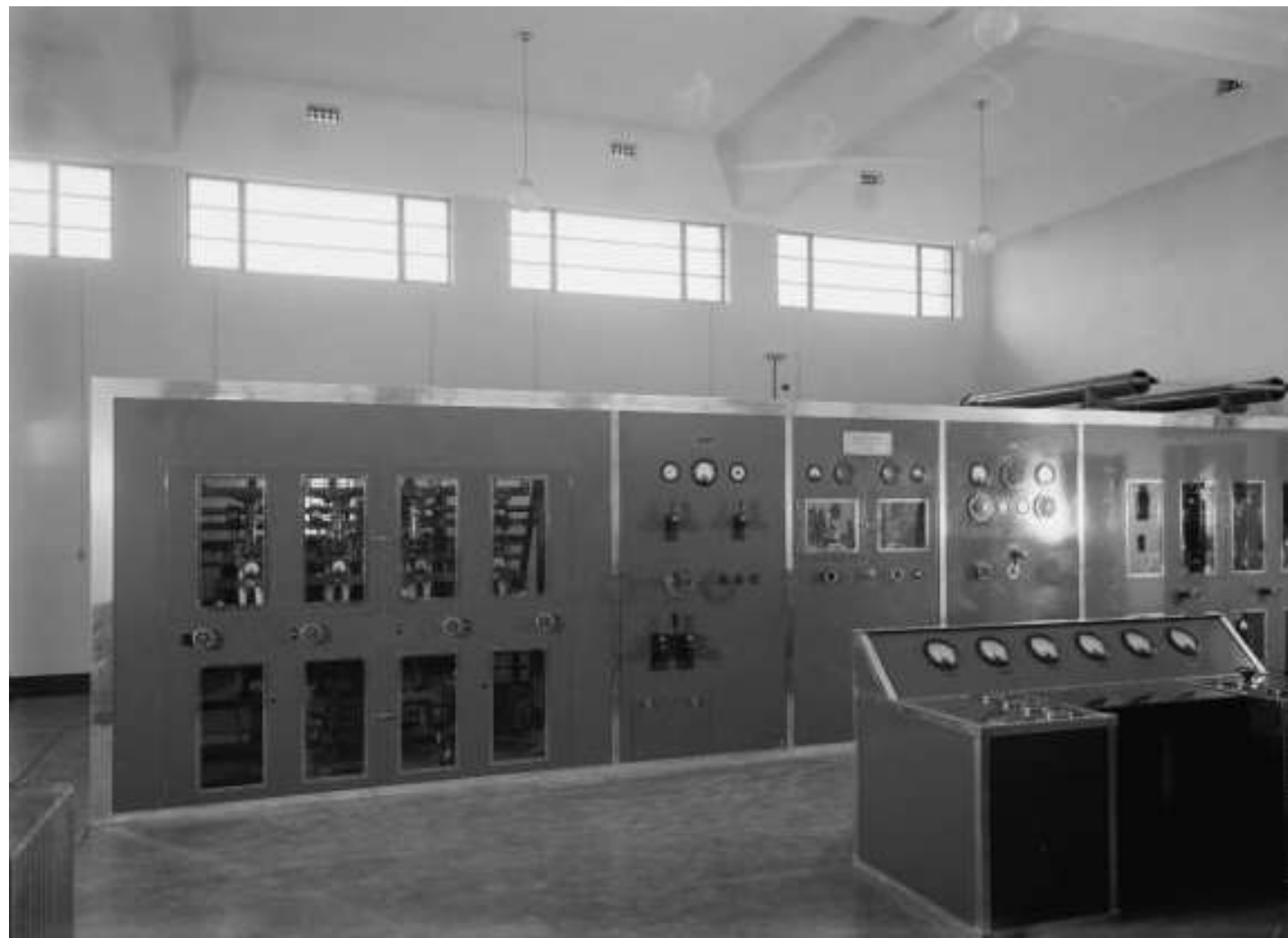
משדר רדיו 20 קילו-וואט ברמאללה, 1936 אוסף אריק ואדית מטסון. באדיבות ספרית הקונגרס ארה"ב
