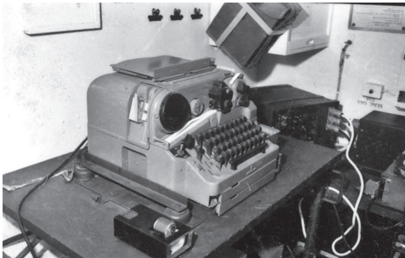
טלפרינטר טפ-4 בתיבת קשר ניידת תק"ש 126 מימין לטפ - טג-9. משמאל לטפ התקן להרטבת הסרט הדביק לשם הדבקתו על טופס מברק. מקור: אוסף העמותה להנצחת חללי חיל הקשר והתקשוב
