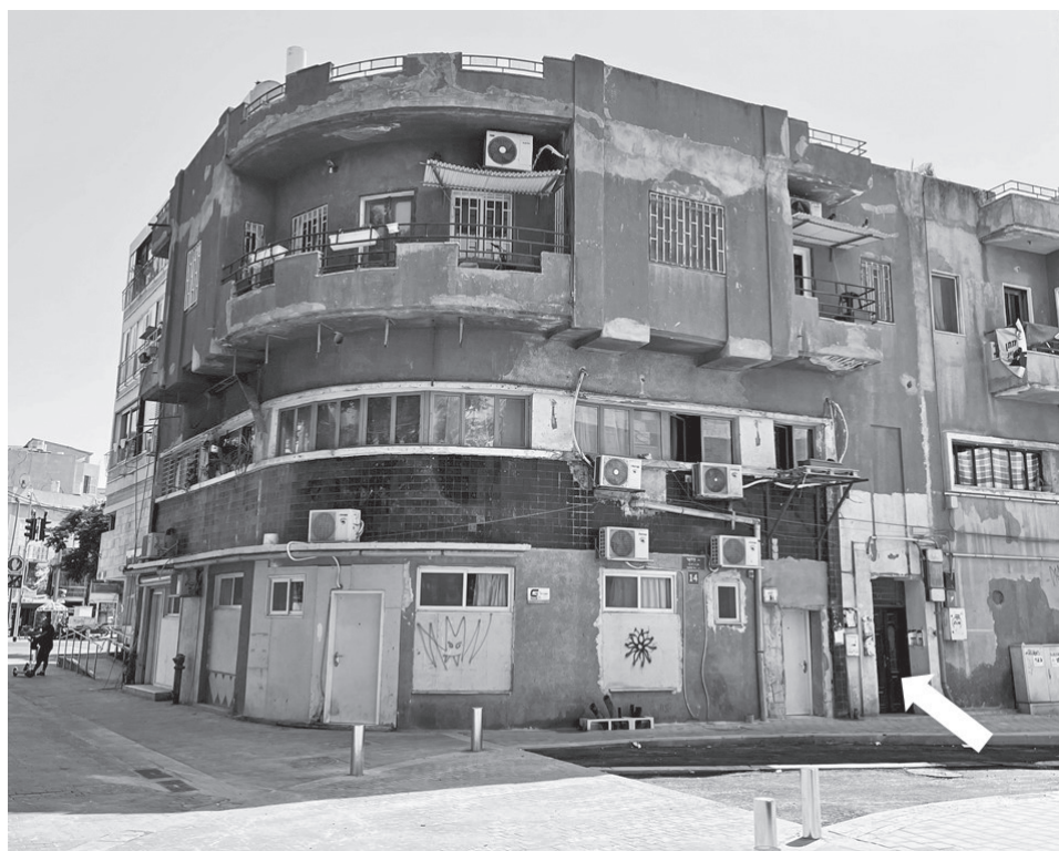
המבנה הראשון של הדואר הצבאי ביפו (היום: רחוב הדואר 14, פינת שדרות ירושלים 14) החץ מימין מצביע על הכניסה ליחידת קצין הדואר של הצבא, ששכנה בקומה השנייה. הגג שימש כמגרש מסדרים. צלם: דניאל רוזן, 2021
