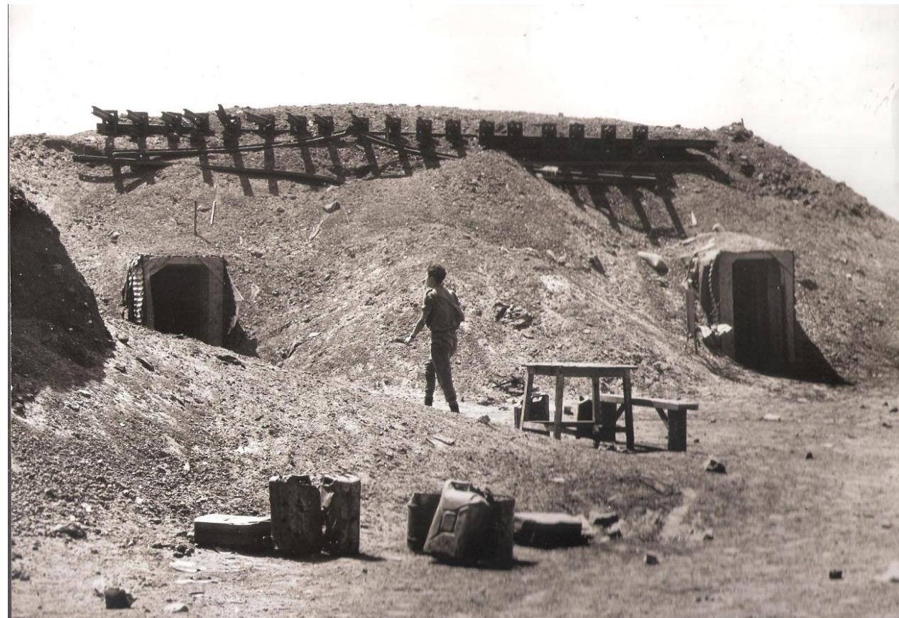
בונקר במעוז בשנת 1970, לפני שדרוג והרחבה
